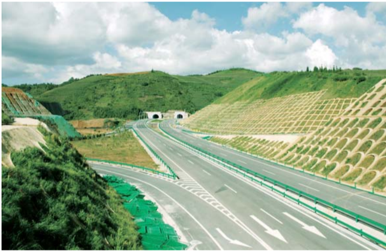
近日,四公司承建的蒙文砚高速公路芷村隧道土建施工、路面施工全部完成,土建施工通过验收,为全线顺利通车打下坚实基础。
