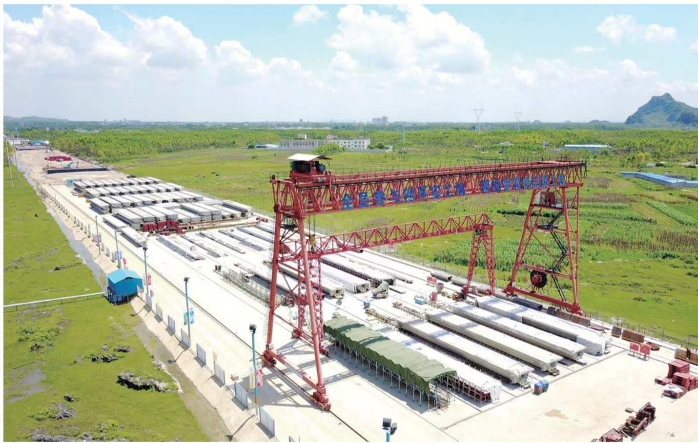
一公司承建的广西贵隆高速 A01 标段制梁场多次受到全线观摩,目前已制梁 186 根,完成总设计量 666 根的 21%。
