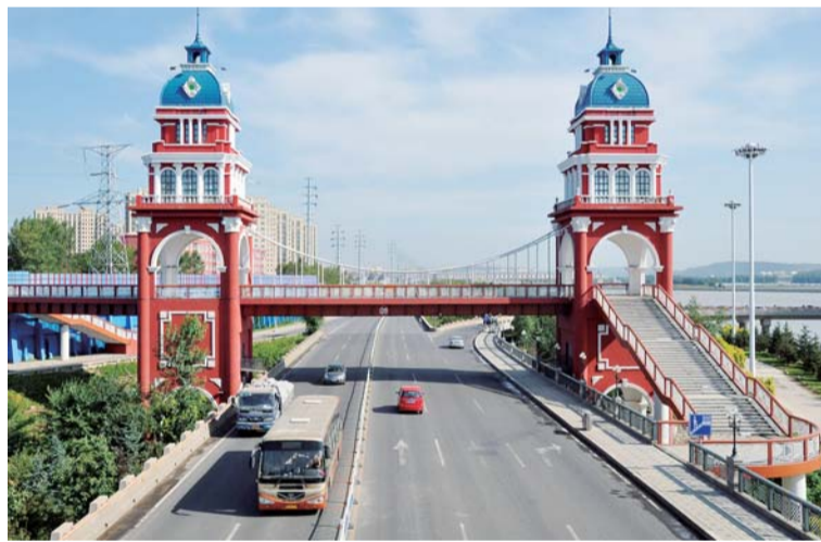
近日,三公司牡丹江项目部承建的黑龙江省牡丹江市东四跨江桥桥头堡改造工程全面竣工。
