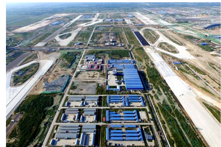
近日，四公司承建的北京新机场工程飞行区场道工程三标段已进入全面大干阶段，目前场道工程水泥稳定土基层施工已基本完成。图为西二跑道滑行道工程。
