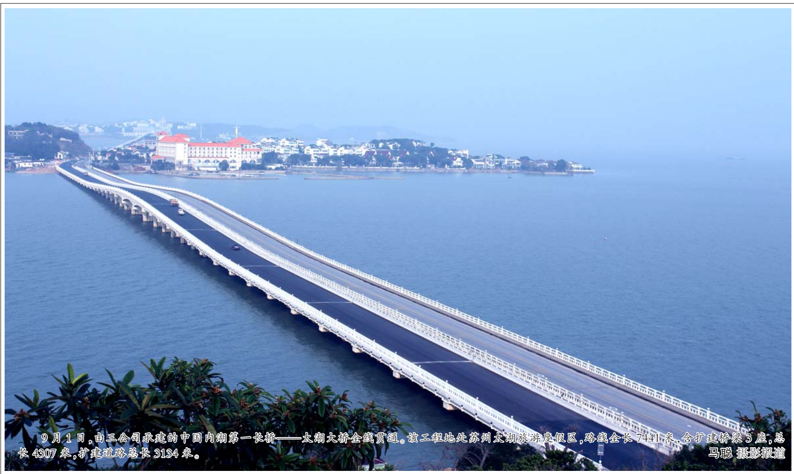
9月1日,由三公司承建的中国内湖第一长桥——太湖尖舍金线贯通。该工程地处苏州太湖旅游度假区,路线全长7411米,含扩建桥梁3座,总长4307米,新建道路总长3134米。
