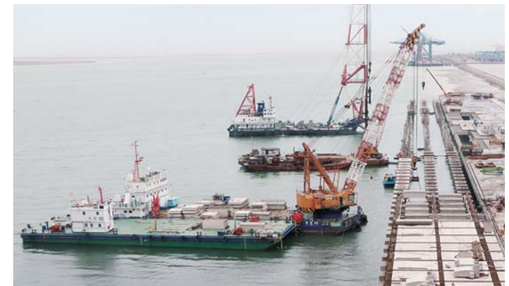
近日，一公司第十七项目部承建的河北钢铁国际物流有限公司通用散货码头工程完成全部沉桩施工。宁跃 摄影报道
