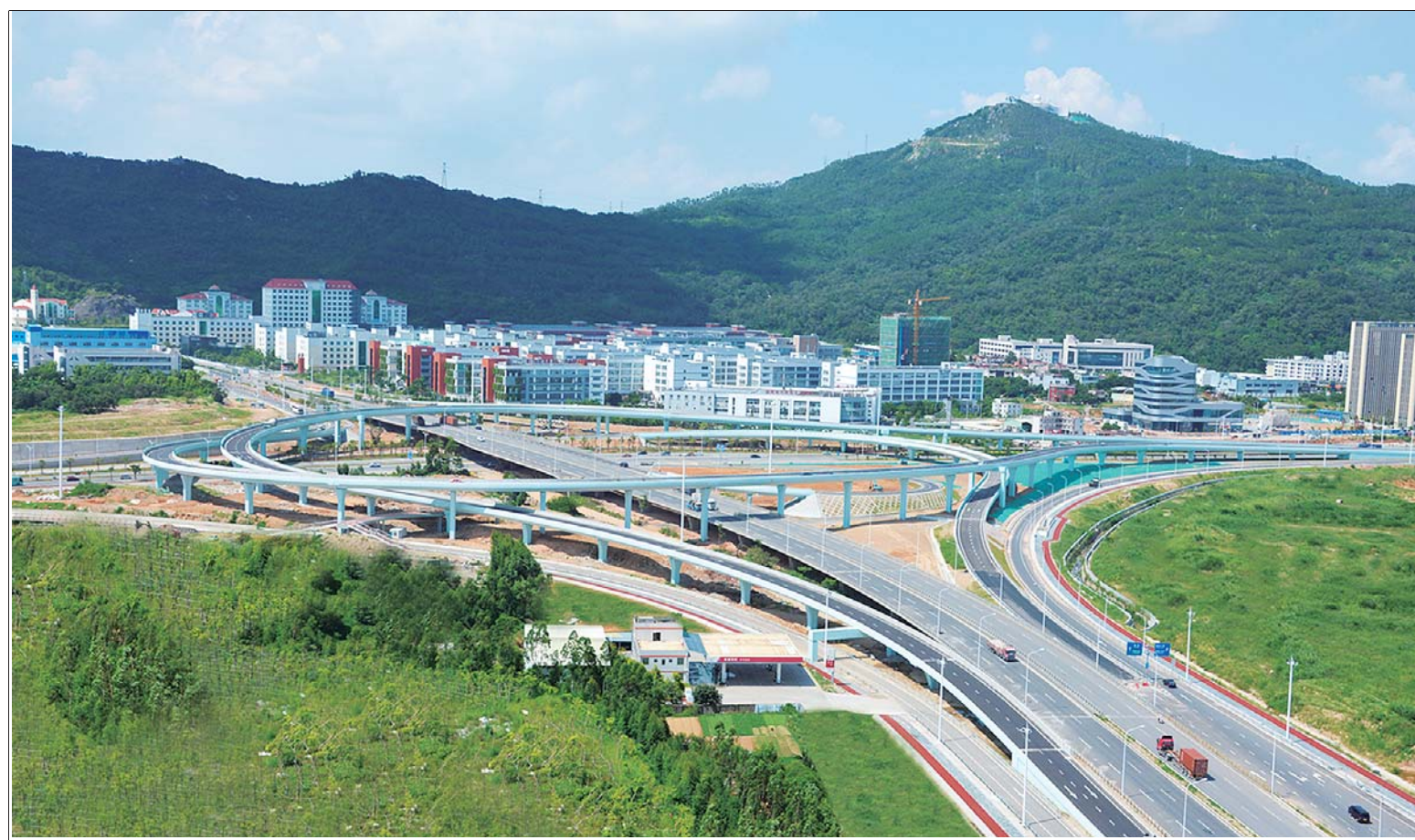
近日，一公司第十一项目部承建的厦门市马青路提升改造A标段工程通过初步验收并全面通车。
