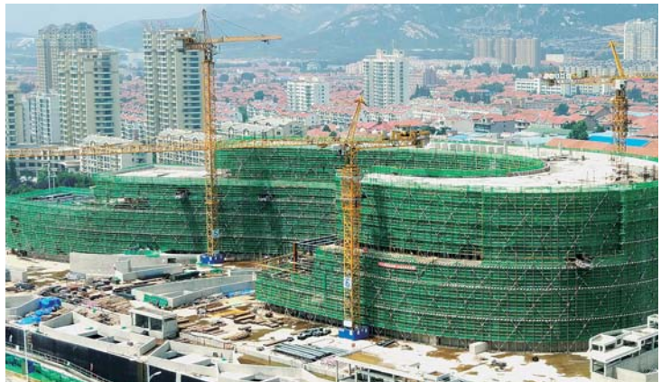
8月7日，二公司承建的青岛地铁13号线灵山卫停车场综合楼顺利封顶。徐冰 摄影报道
