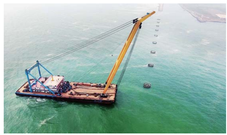
近日，五公司承建的绥中电厂二期工程配套码头项目海域工程引桥工程完成全部沉箱安装。徐鸿玉 李迎雨 摄影报道
