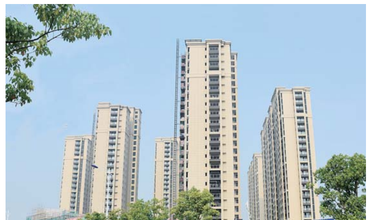
近日，四公司承建的南京海峡两岸科工园海科新寓棚户区改造安置房B区一期开发项目外墙施工全部完成。江海洋 摄影报道
