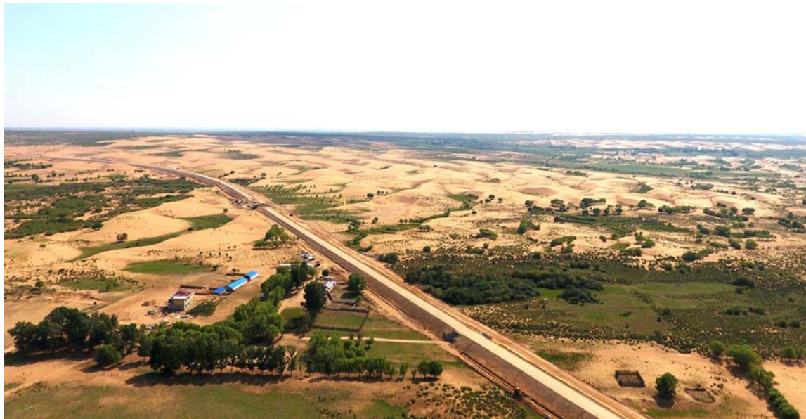
蒙华项目施工现场 杨位法 摄
