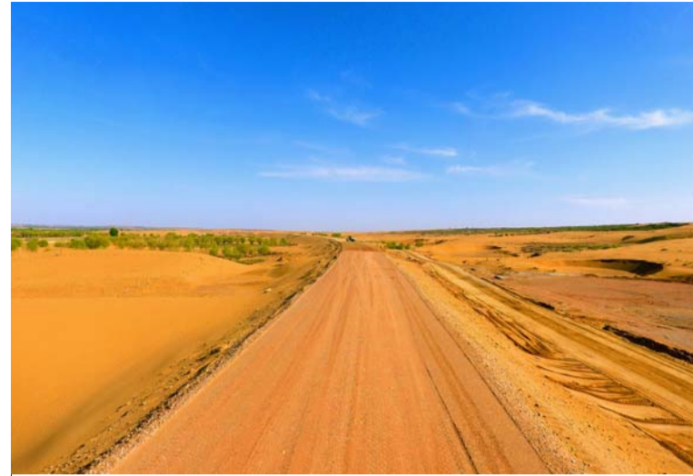
近日，二公司承建的豪华项目二工区 DK65+725-DK74+290 段通过验收，标志着标段内首段路基主体工程完工。
