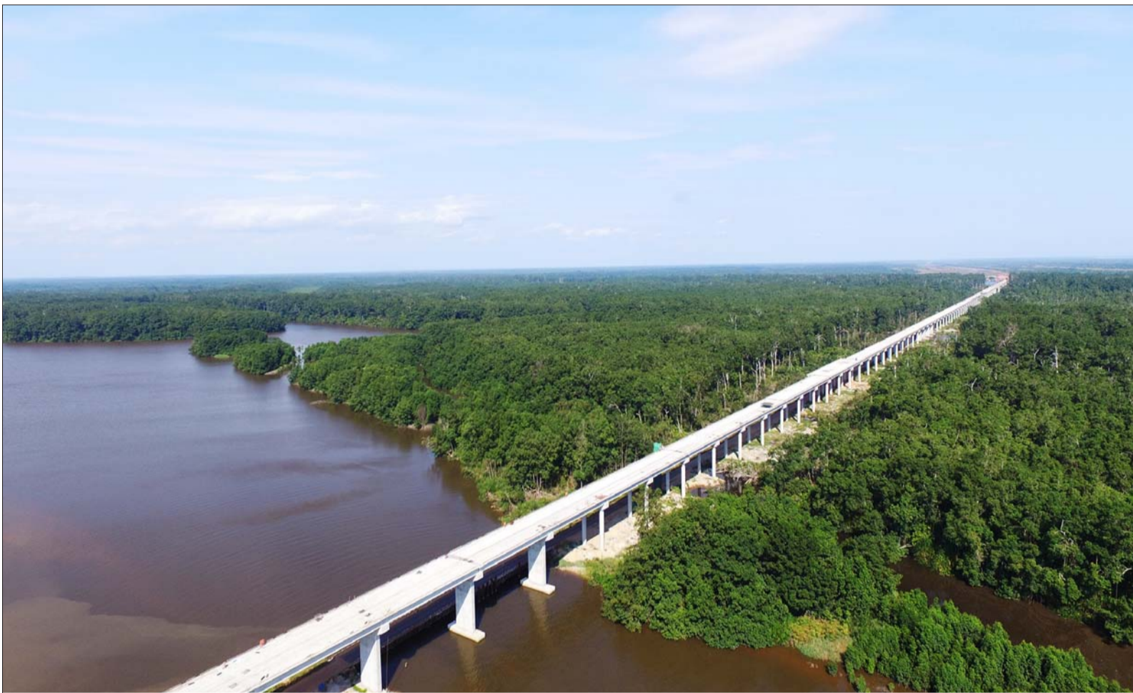
近日，由中国路桥总承包、四公司负责施工的加蓬 PO 公路奥果韦河特大桥 T 梁预制全部完成，T 梁架设接近尾声，预计今年 10 月大桥可实现贯通。据了解，奥果韦河特大桥全长 4707 米，建成后将成为非洲第三长桥。
