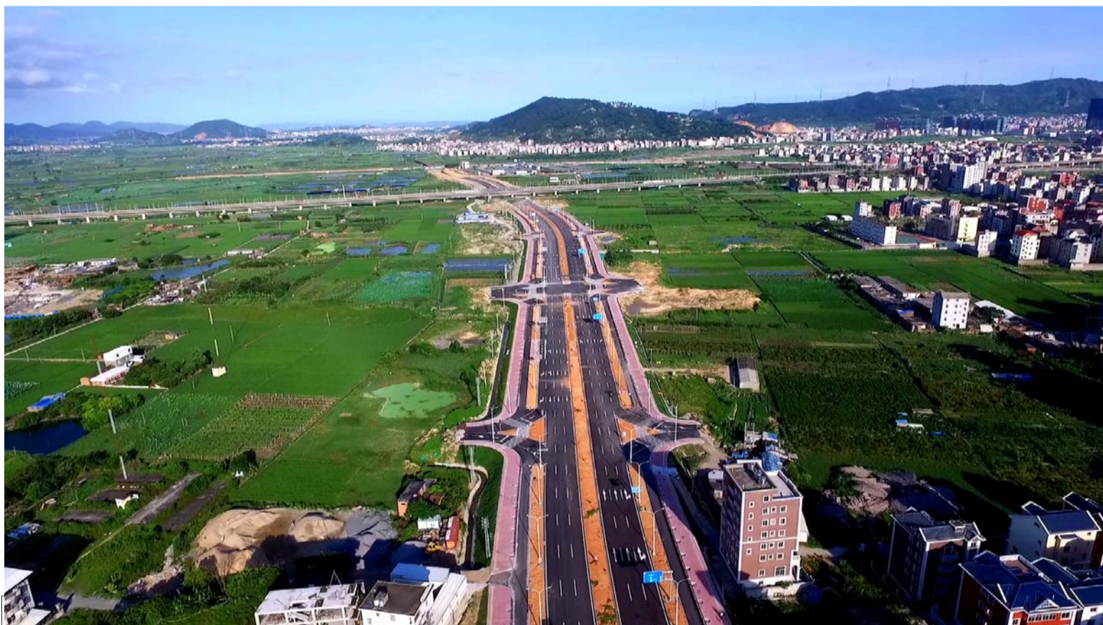
近日，二公司福建分公司承建的福清市外环路（清昌大道—瑞亭街至融宽路段）道路工程完成竣工验收。清昌大道全长0.97公里，于2014年9月开工，2017年3月通过竣工验收。 孙开轩 摄影报道
