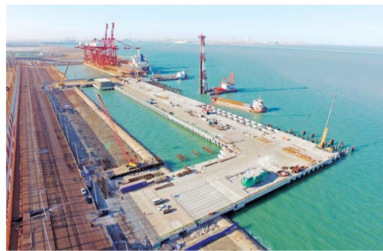
近日，一公司第九项目部承建的天津港南疆27号通用码头工程完成全部桩基施工任务。申文永 杨明夷 摄影报道
