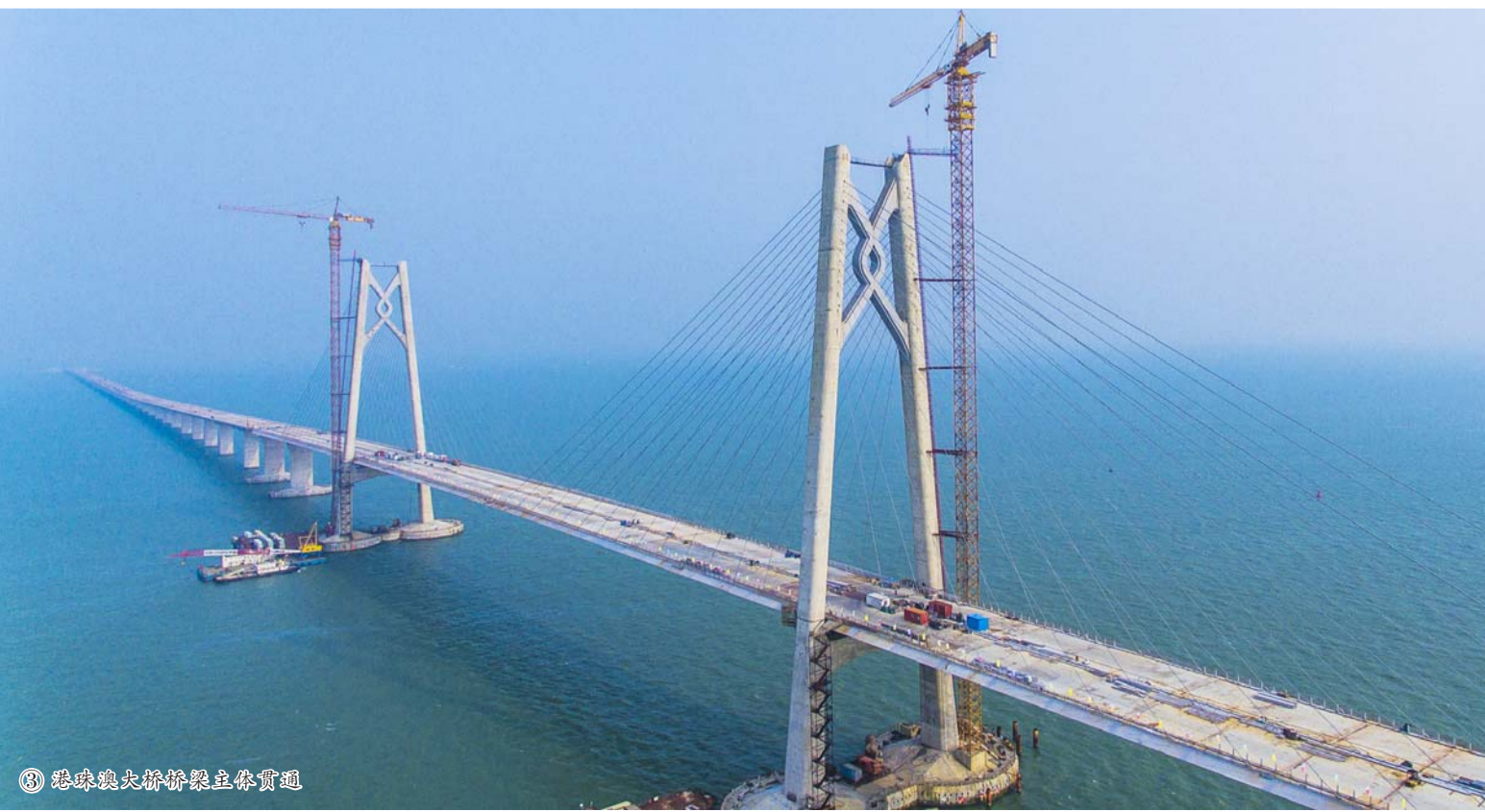
⑨ 珠澳 LNG 项目一期码头工程
