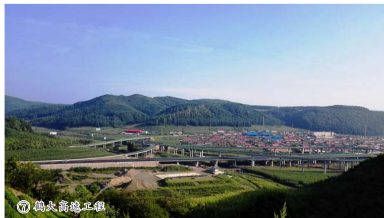
⑥ 京沈高铁工程
